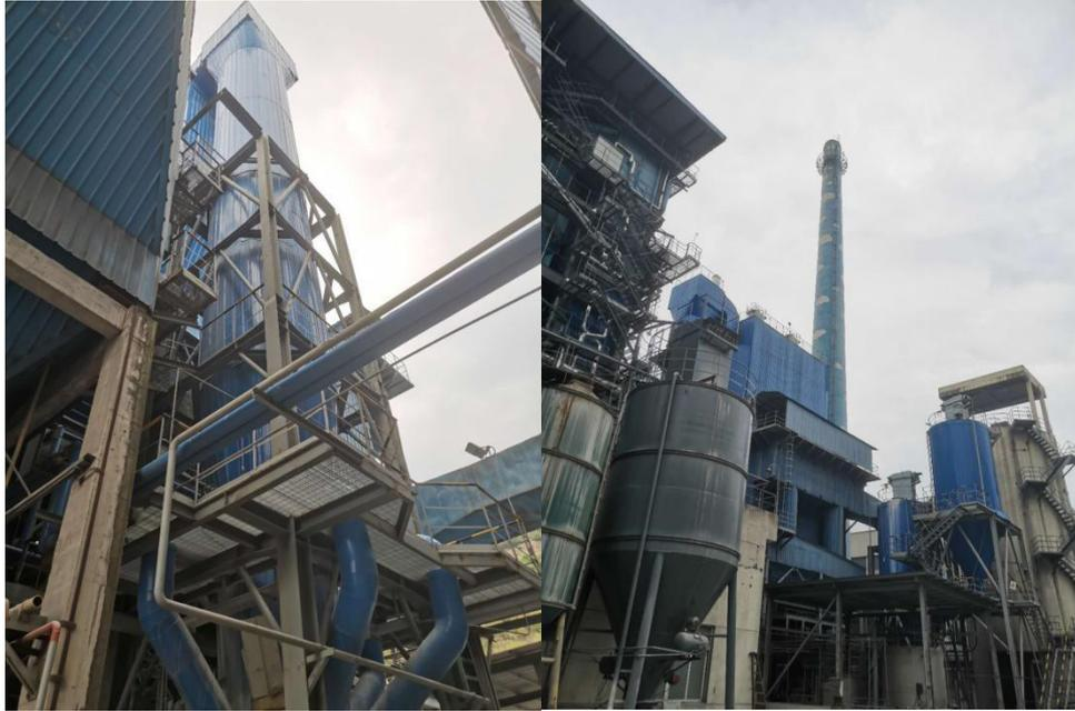
图4-5 静电预除尘+半干法脱硫+布袋除尘+80m烟囱现场照片
