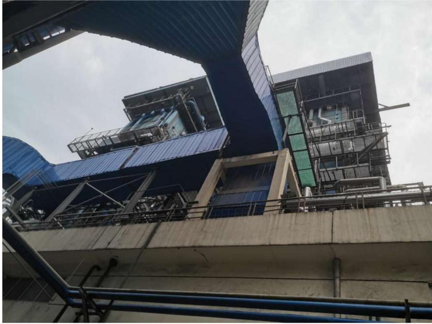
图4-3 SNCR+SCR脱销现场照片（左边35吨锅炉，右边45吨锅炉）
